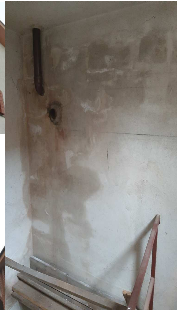
Elewacja wieży wewnątrz
