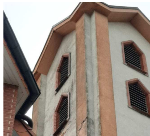
Elewacja wieży z zewnątrz
