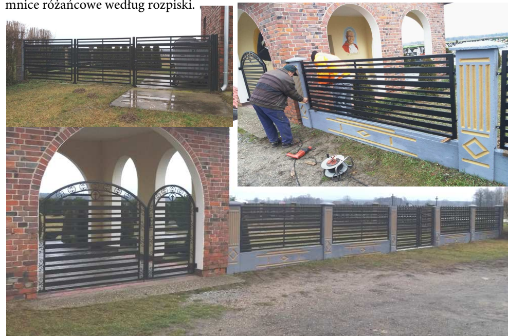
Montaż ogrodzenia cmentarza od strony parkingu /grudzień 2019 r./
