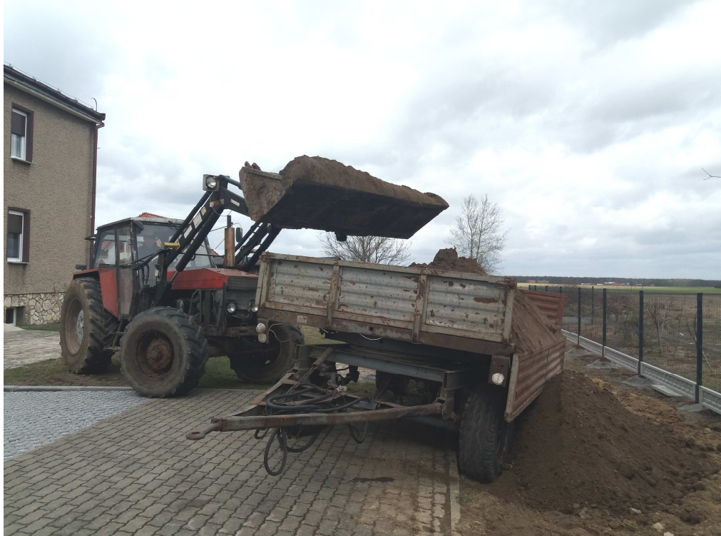
przygotowanie terenu pod montaż nowego płotu od strony plebanii
