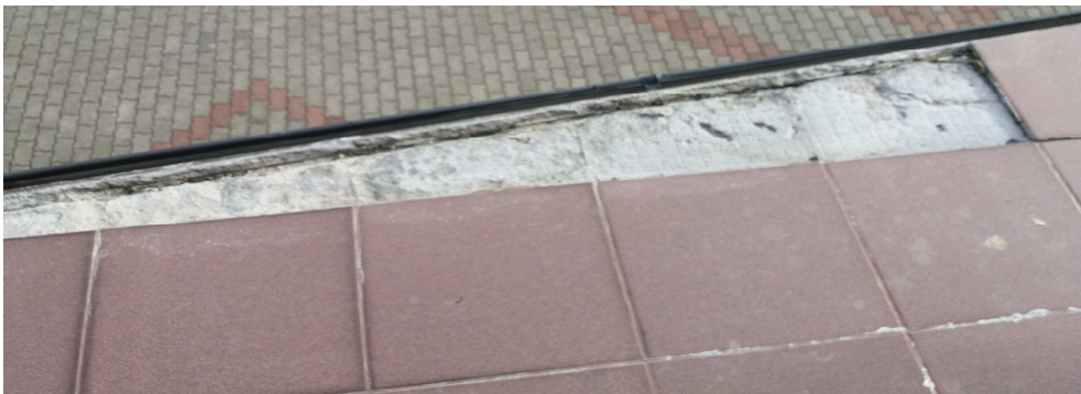
Uszkodzony daszek nad wejściem do kościoła
